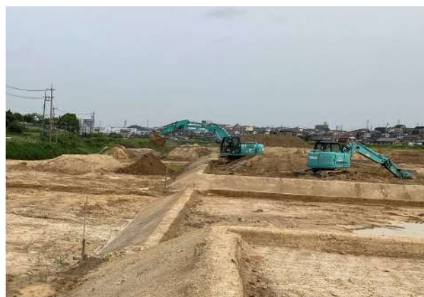
搬入土砂配分工事の様子
