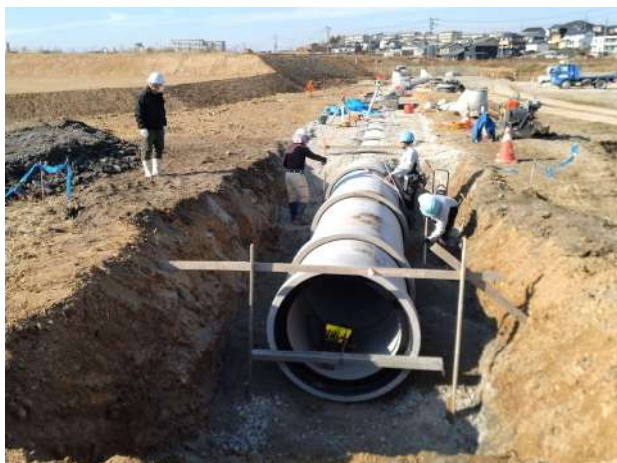
ヒューム管設置の様子
